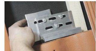
C. Shimsa grundplatta så den sticker upp några mm högre än underliggande takpannas dal. Shimms kan beställas.
