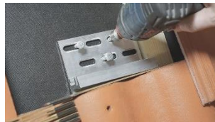
B. Placera grundplatta centrerat och cirka 2–3 mm fritt från underliggande takpannas dal. Förskruva men drag EJ åt.
