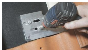
E. Drag åt grundplatta vid önskad höjd.
