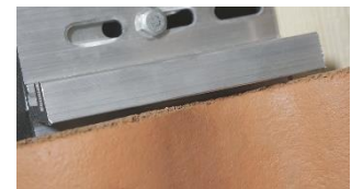
F. Bekräfta avstånd mellan grundplatta och takpanna.
