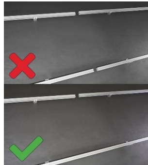
Skarvar på skenor skall förskjutas och får EJ placeras under samma solcellspanel.
