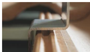
B. Sidofäste skall hänga fritt ca 2–3 mm från underliggande takpanna
