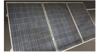
F. Avsluta panelrad med ändklämmor. Bild visar färdigt montage för en rad med 3 st solcellspaneler, stående layout.
