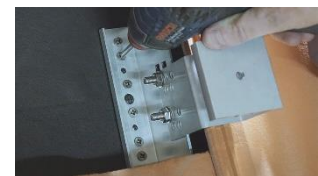
C. Skruva fast grundfäste i underlag. Använd 5-6st. träskruv
