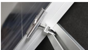
D. Skjut intill mittklämma mot solcellspanel.
