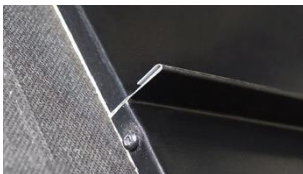
A. Notera falsomslag på takplåt. Placera falsklämma.
