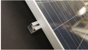
A. Placera solcellspanelen på skenor.
