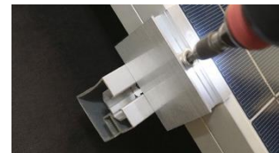
F. Skjut intill ändklämma mot solcellspanel och drag åt. Åtdragningsmoment 6–8 Nm
