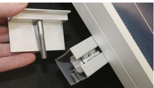
D. För i insexskruv i ändklämma.
