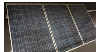
F. Avsluta panelrad med ändklämmor.
