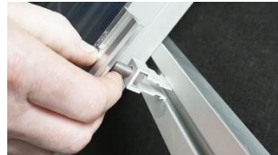
B. Placera mittklämmans clips i skena och tryck i för hand.
