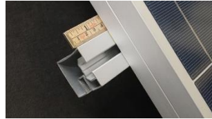
B. Skena behöver sticka ut minst 40 mm.
