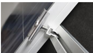
D. Skjut intill mittklämma mot solcellspanel.
