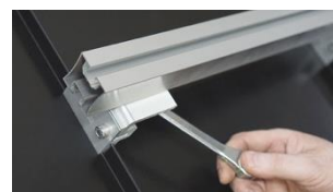
C. Drag åt skena med M10 flänsmutter. Åtdragningsmoment 20-25 Nm
