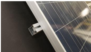
A. Placera solcellspanelen på skenor.
