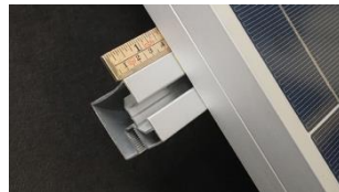
B. Skena behöver sticka ut minst 40 mm.
