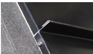
A. Notera falsomslag på takplåt. Placera falsklämma.
