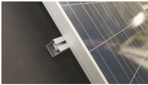
A. Placera solcellspanelen på skenor.
