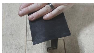
B. Fäst EPDM gummi på undersida av skena, för att undvika galvaniska strömmar.
