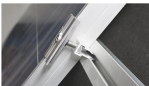
D. Skjut intill mittklämma mot solcellspanel.
