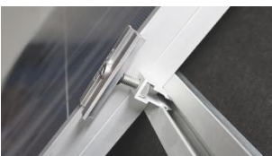
D. Skjut intill mittklämma mot solcellspanel.
