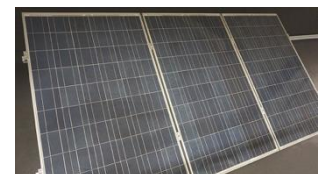
F. Avsluta panelrad med ändklämmor.
