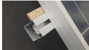
B. Skena behöver sticka ut minst 40 mm.
