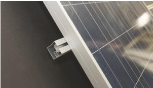
A. Placera solcellspanelen på skenor.
