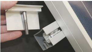
D. För i lång insexskruv i ändklämma.
