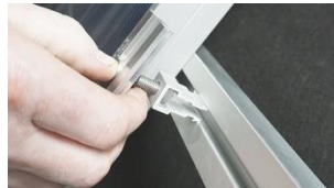
B. Placera mittklämmans clips i skena och tryck i för hand.
