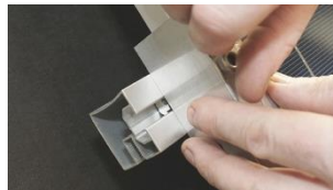
E. Gänga i ändklämma och insexskruv för hand, för att undvika korsgängning.
