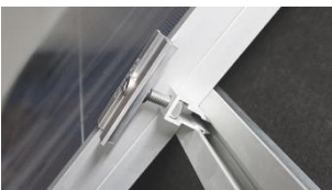
D. Skjut intill mittklämma mot solcellspanel.
