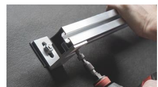
C. Drag åt skena med kort insexskruv. Åtdragningsmoment 12 Nm
