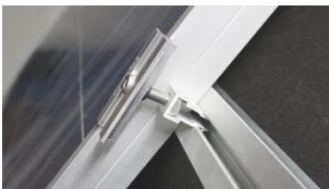
D. Skjut intill mittklämma mot solcellspanel.
