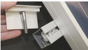
D. För i lång insexskruv i ändklämma.
