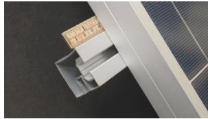
B. Skena behöver sticka ut minst 40 mm.
