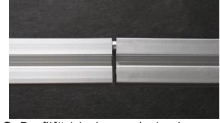
C. Profilförbindarens bula skapar en liten glipa.
