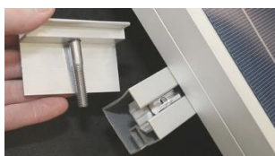
D. För i lång M8 insexskruv i ändklämma.
