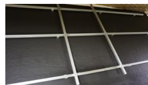
C. CC mått mellan vertikala skenor se rekommendation från paneltillverkare.
