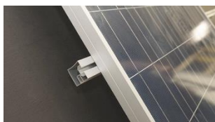
A. Placera solcellspanelen på skenor.
