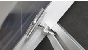
D. Skjut intill mittklämma mot solcellspanel.
