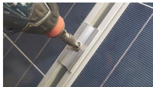
E. Skjut intill nästkommande solcellspanel och drag åt. Åtdragningsmoment 12 Nm
