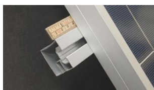
B. Skena behöver sticka ut minst 40 mm.
