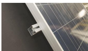
A. Placera solcellspanelen på skenor.
