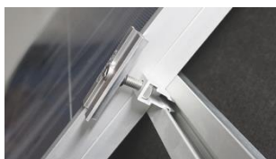
D. Skjut intill mittklämma mot solcellspanel.
