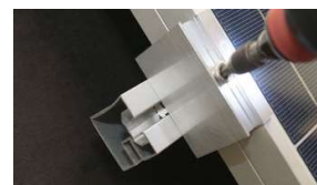
F. Skjut intill ändklämma mot solcellspanel och drag åt. Åtdragningsmoment 12 Nm
