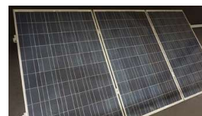
F. Avsluta panelrad med ändklämmor.
