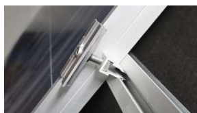
D. Skjut intill mittklämma mot solcellspanel.
