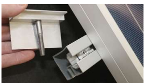
D. För i insexskruv i ändklämma.
