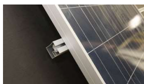
A. Placera solcellspanelen på skenor.
