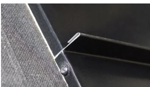
A. Notera falsomslag på takplåt. Placera falsklämma
