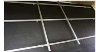
C. CC mått mellan vertikala skenor se rekommendation från paneltillverkare.
