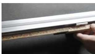
B. Överhäng på skena får vara Max 250 mm.
