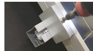
F. Skjut intill ändklämma mot solcellspanel och drag åt. Åtdragningsmoment 12 Nm
