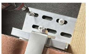
A. Skruva fast grundplatta med 3 st träskruv.
