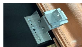
F. Alternativ 2 – Liggande layout. För liggande layout, montera adapter enligt bild. Drag åt insexskruv.
