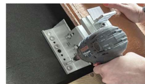
C. Skruva fast grundfäste i underlag. Använd 5st. träskruv
