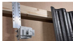
C. Skruva fast läkttfästet i underlag. Använd 5st. träskruv.
