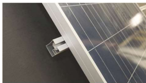
A. Placera solcellspanelen på skenor.
