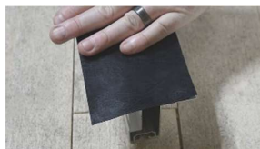
B. Fäst EPDM gummi på undersida av skena, för att undvika galvaniska strömmar.
