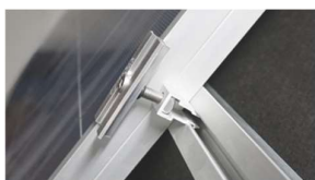
D. Skjut intill mittklämma mot solcellspanel.
