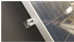
A. Placera solcellspanelen på skenor.
