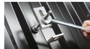
C. Drag åt montagefäste. Åtdragningsmoment 20–25 Nm
