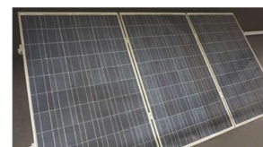
F. Avsluta panelrad med ändklämmor.
