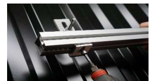
C. Drag åt skena med M8 insexskruv Kort Åtdragningsmoment 12 Nm
