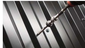
B. Tag fram stockskruv och skruva i tills endast M-gänga är synlig.
