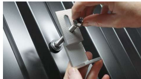
B. Placera fäste över stockskruv och justera till önskad höjd och position.
