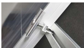
D. Skjut intill mittklämma mot solcellspanel.
