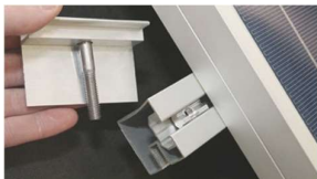
D. Lång insexskruv i ändklämma.
