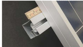
B. Skena behöver sticka ut minst 40 mm.
