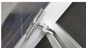
D. Skjut intill mittklämma mot solcellspanel.
