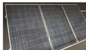
F. Avsluta panelrad med ändklämmor. Bild visar färdigt montage för en rad med 3 st solcellspaneler, stående layout.
