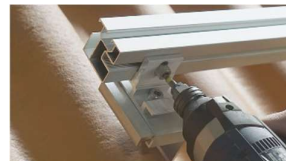
C. Drag åt skena med kort insexskruv. Åtdragningsmoment 12 Nm
