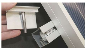
D. För i lång insexskruv i ändklämma.
