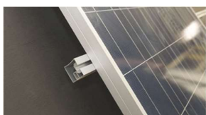
A. Placera solcellspanelen på skenor.
