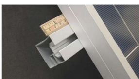
B. Skena behöver sticka ut minst 40 mm.
