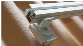
A. Placera skena med räfflat spår mot adapter.
