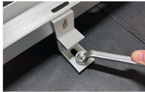
E. skruva fast adapter på infästningsplatta
