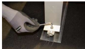
E. Skjut intill ändklämma mot solcellspanel Dra åt skruv till bakben Åtdragningsmoment 12 Nm
