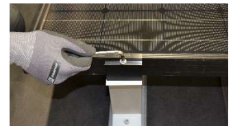
F. Drag åt insexskruv ändklämma Åtdragningsmoment 12 Nm
