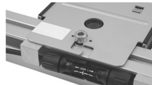
C. Skjut intill optimerare i skruvsats och drag åt.
