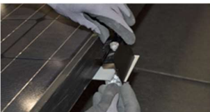
D. Montera ändklämma, i fram och bakbenets spår.
