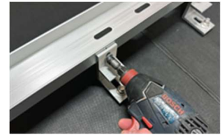
F. Skruva fast brygga.
