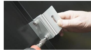
C. Flytta klämma till önskad position på fals och drag åt M8. Åtdragningsmoment 8-10 Nm
