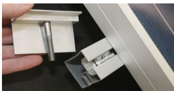
J. För i insexskruv i ändklämma
